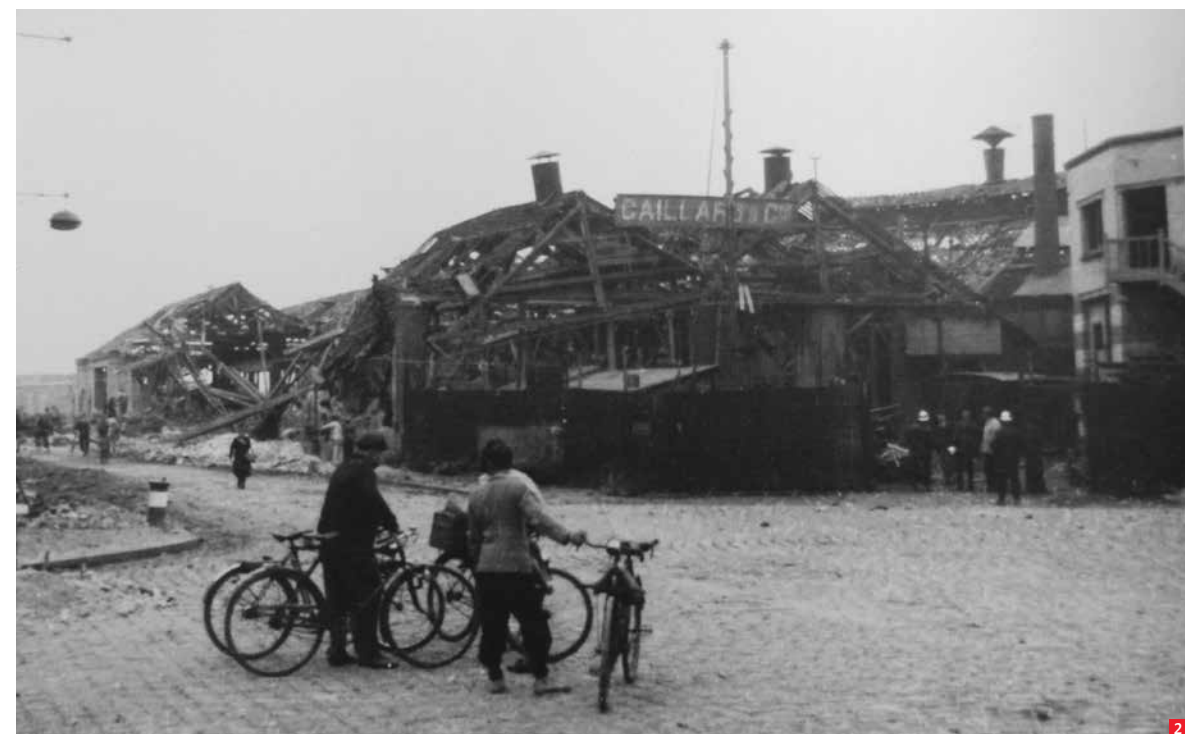
2 ADSM 237 w58, vue partielle des dommages subis par l'entreprise Caillard.
