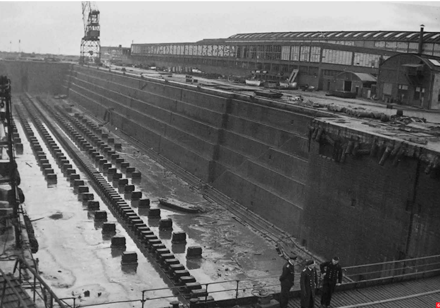
6 Côte Fi-62, remise en état de la forme de radoub n°7 (on aperçoit les ateliers de la Compagnie Générale Transatlantique). Album Eric Werder, archives municipales du Havre.
