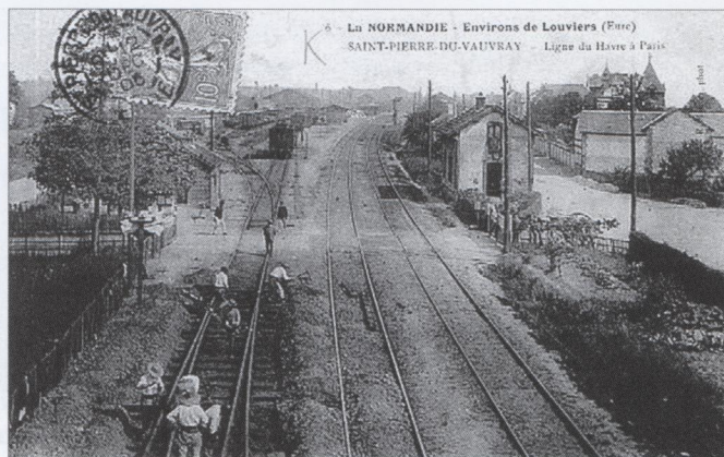
Construction de la ligne de chemins de fer près de Louviers
